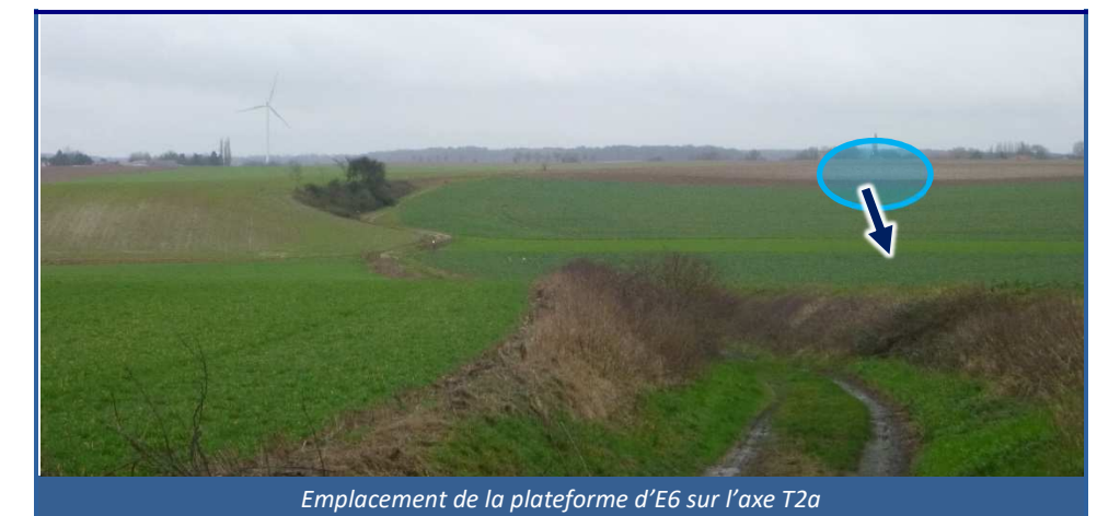
Photo 2 : Emplacement de la plateforme d'E6 sur l'axe T2a
